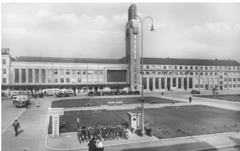
Obrázek 2: Nová nádražní budova hradeckého hlavního nádraží ve 30. letech 20. století [6]
